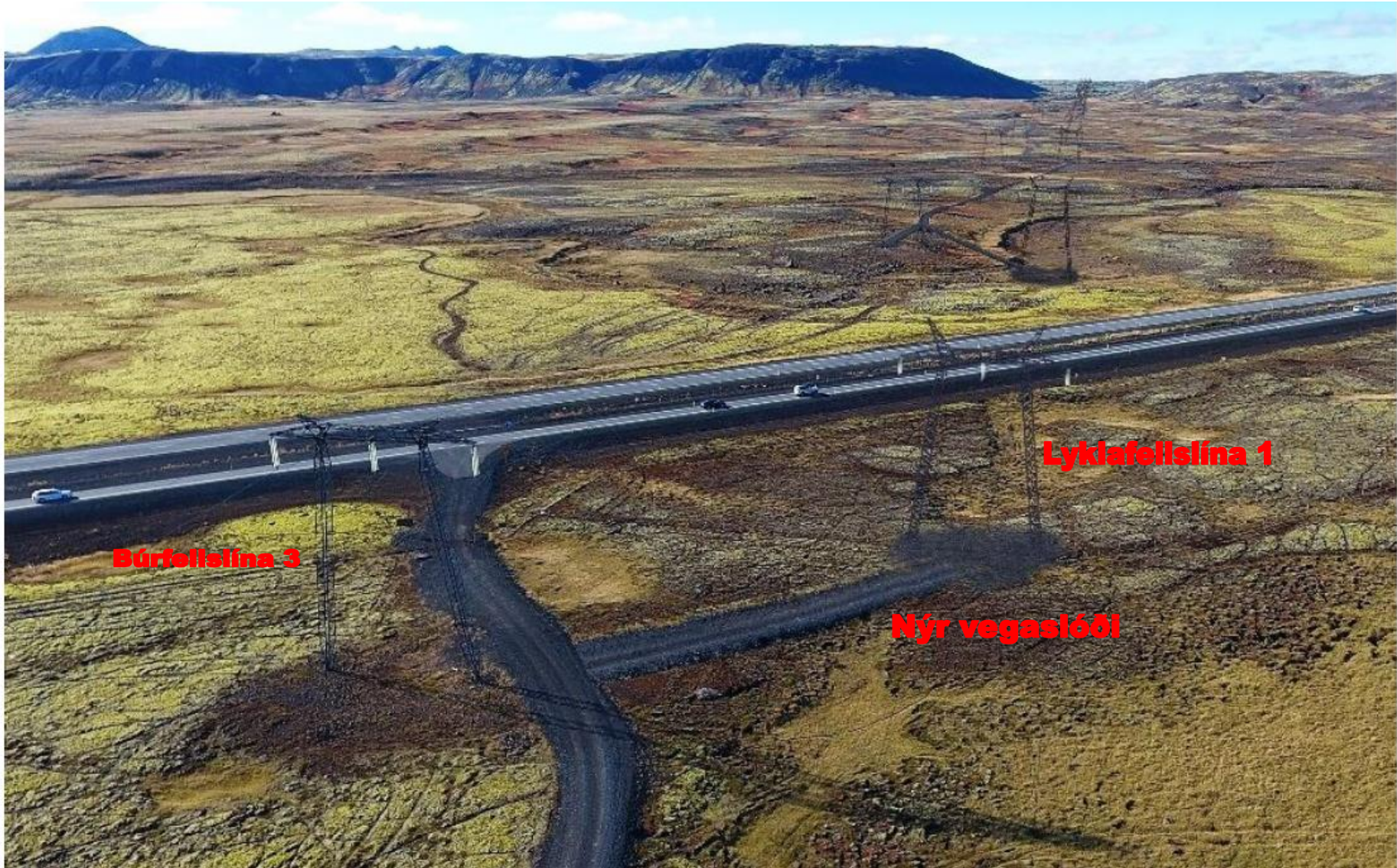
Mynd 21. Ásýnd á Búrfellslínu 3 og Sandskeiðslínu 1 eftir byggingu þeirrar síðarnefndu, horft yfir Suðurlandsveg til suðvesturs.
