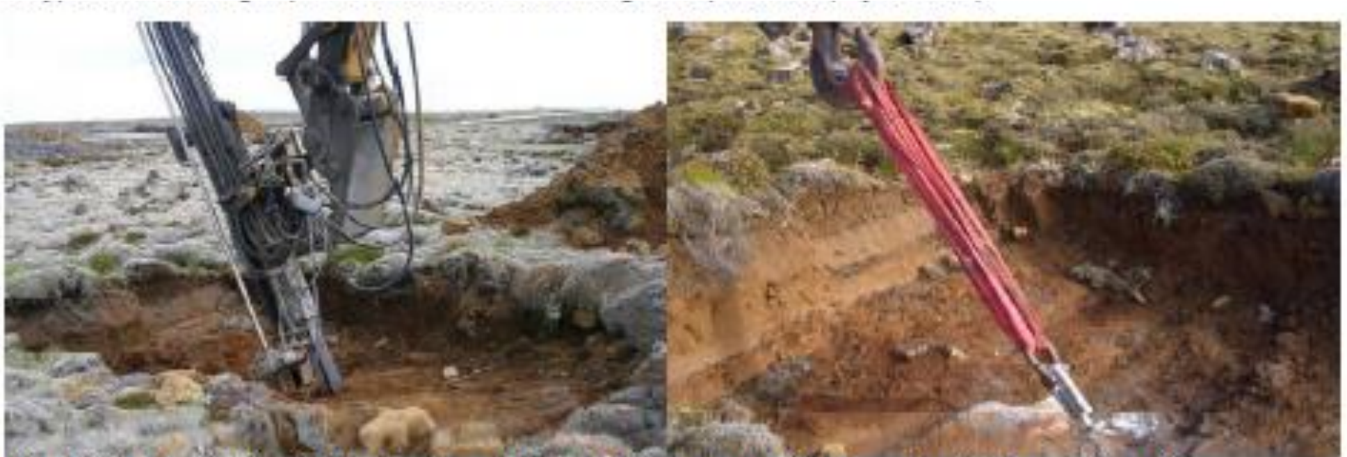
Mynd 2.38 Til vinstri sér hvar borað er fyrir bergbolta og myndin til hægri sýnir bergboltaprófun.
