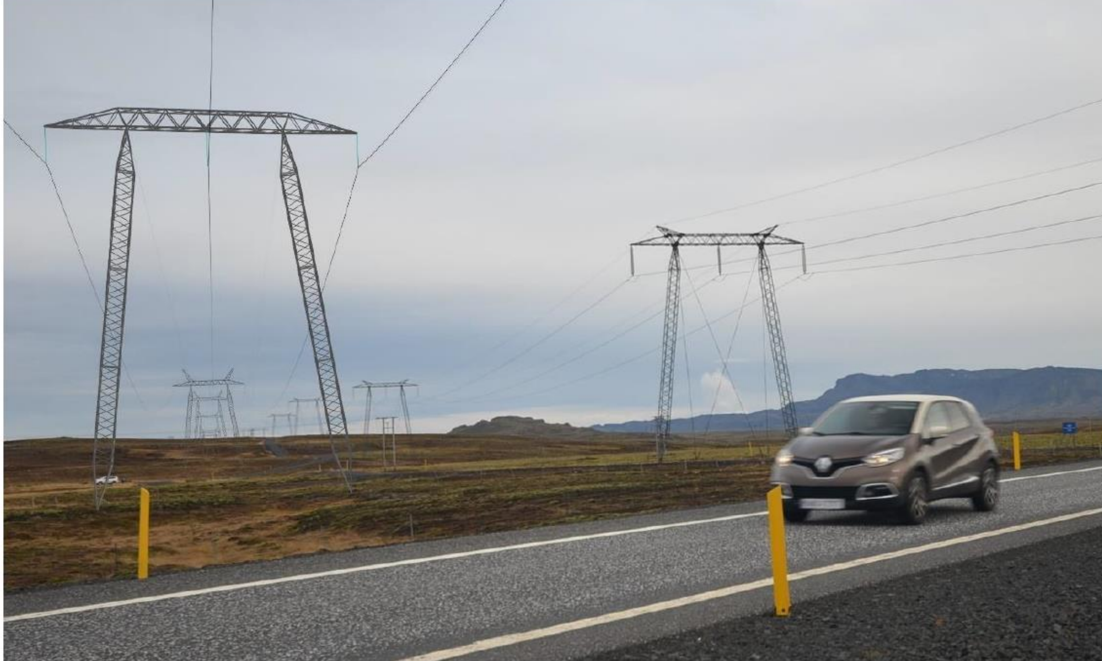
Mynd 23. Ásýnd á 220 kV Búrfellslínu 3 og Sandskeiðslínu 1 eftir byggingu þeirrar síðarnefndu, horft yfir Suðurlandsveg til norðausturs. Sandskeiðslína 1 er til vinstri á mynd.
